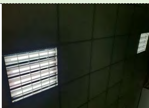
照明設備更換前
